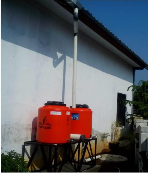
Salah satu model panen air hujan yang dikembangkan Dinas Lingkungan Hidup Kota Semarang. Air hujan memiliki kualitas terbaik jika pemanen dan pengelolaan dilakukan dengan benar – Doc. DLH Kota Semarang
